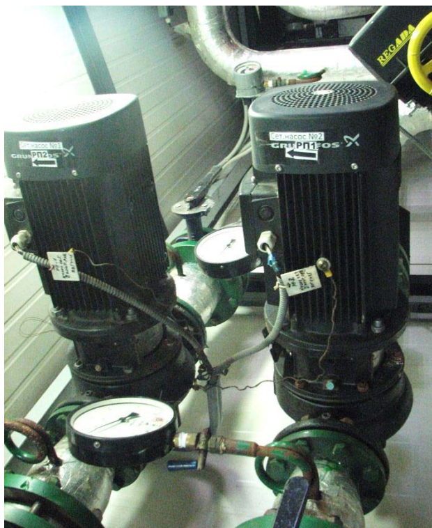
Рисунок 1.3 – Сетевые насосы котельной с. Киевка
