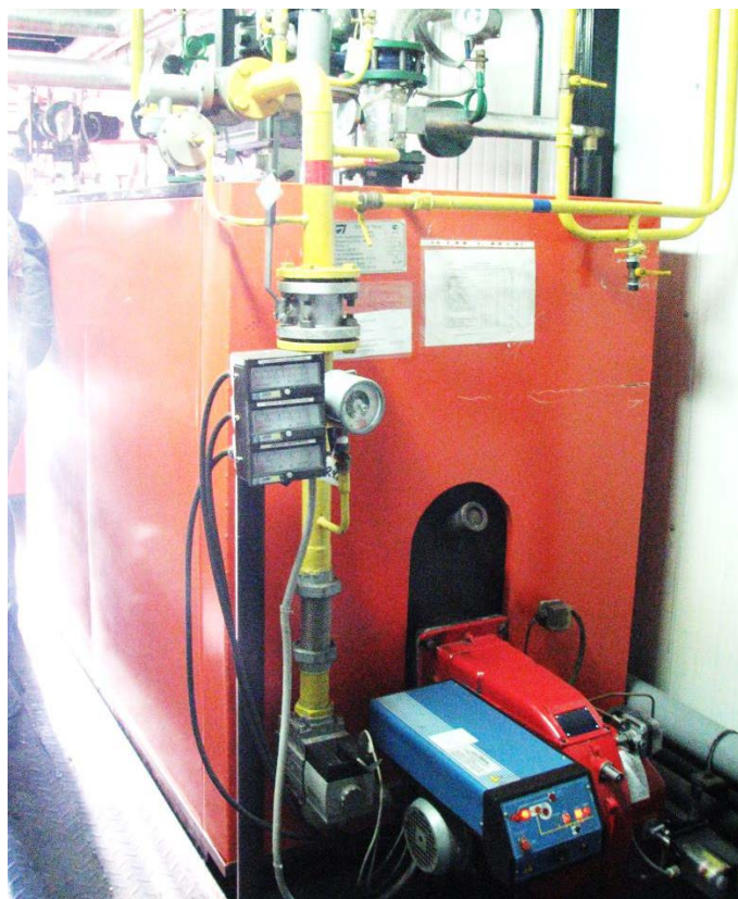
Рисунок 1.2 – Котел «КВСА-0,6» установленный на котельной с. Киевка
